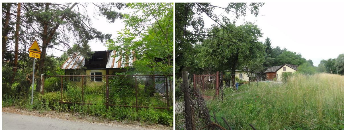
Fot. 21. Istniejąca zabudowa w terenach MW.3 (z lewej strony) i MW.7 (z prawej strony) (lipiec 2021r.).
