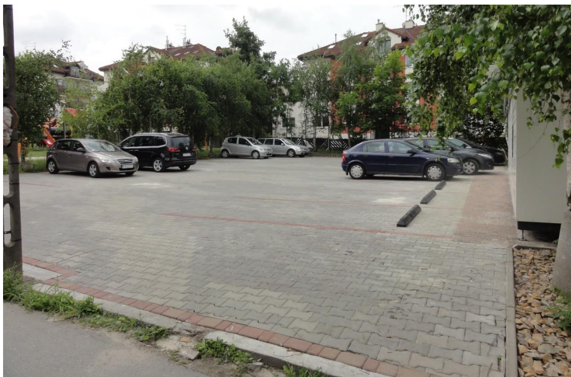
Fot. 16. Parking przy ul. Gwiazdziej z twardą nawierzchnią jako przykład uszczelnienia zlewni (lipiec 2021r.)
