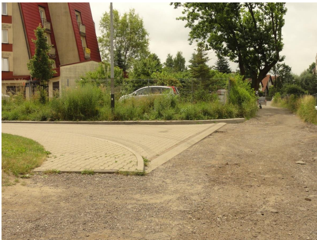
Fot. 13. Fragment obecnego układu komunikacyjnego w obszarze projektowanego planu. Widoczny teren KDL.3 oraz teren KDD.7 (na wprost) (lipiec 2021 r.)
