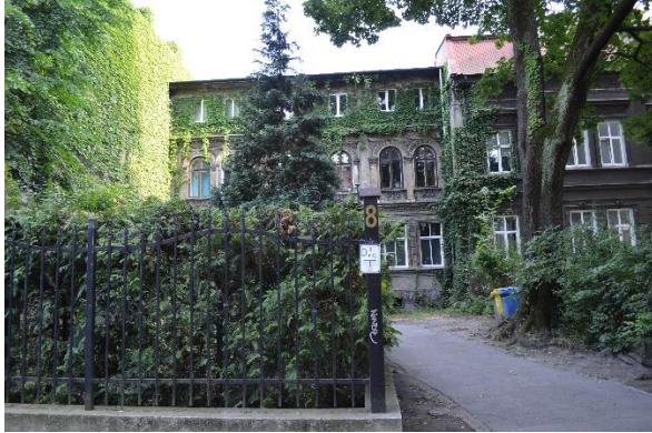
Fot. 6. Ogród przed fasadą kamienicy na ul. Siemiradzkiego 8.
