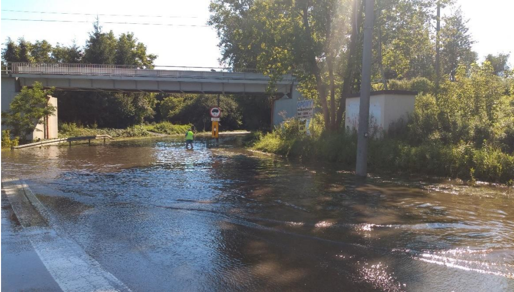
Fot. 9. Podtopienie w rejonie skrzyżowania ul. Półłanki z ul. Agatową, sierpień 2021r.
