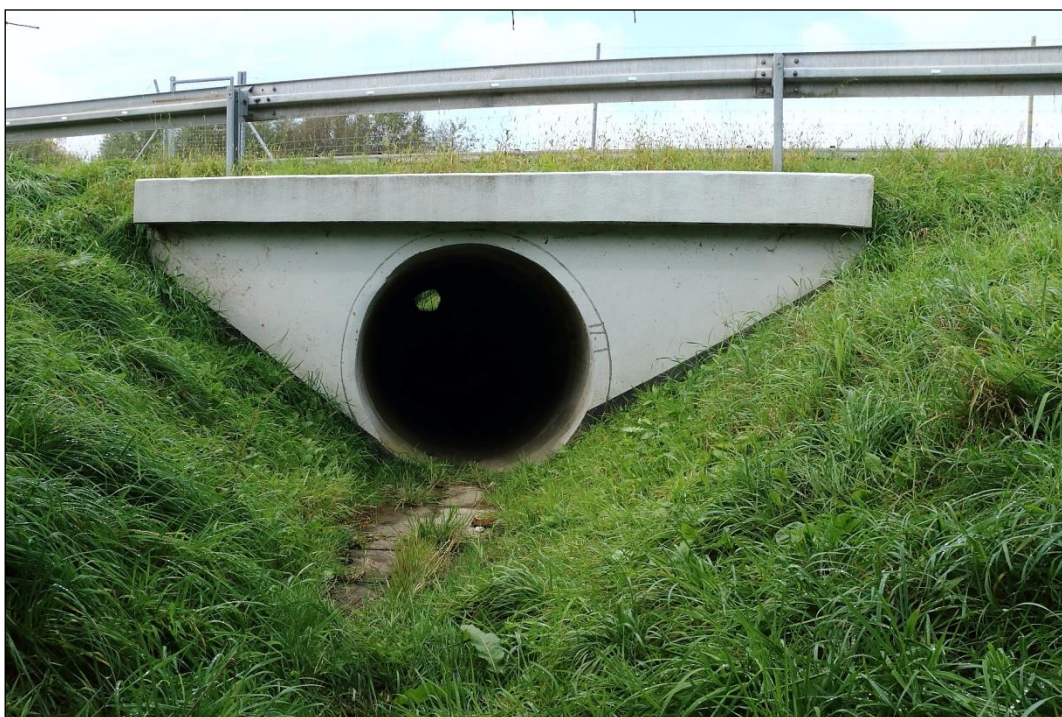
Fot. 6 Przepust pod autostradą A4. Zbiera wszystkie wody z części obszaru planu należącej do zlewni P. Kryspinowskiego, widok w kierunku zachodnim, w dół biegu, 03.10.2019 r.
