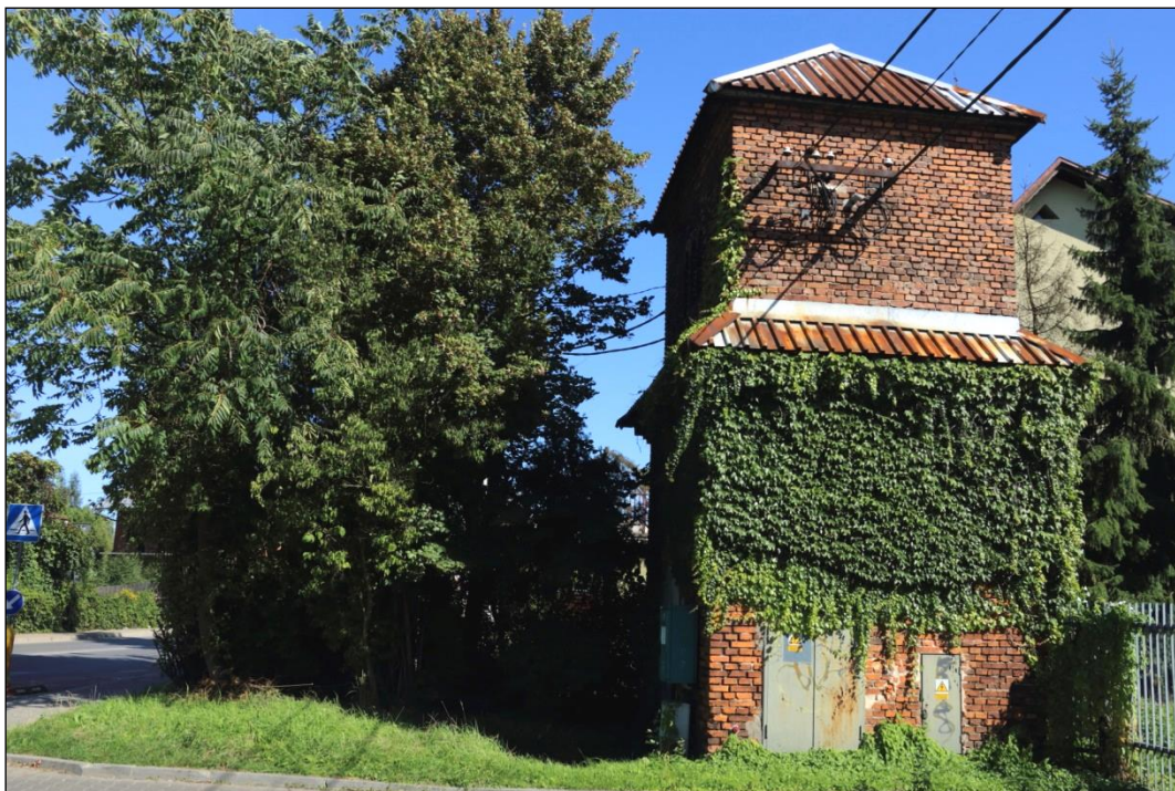
Fot. 23 Historyczna trafostacja przy rondzie w Chełmie. Widok w kierunku południowo-wschodnim, 14.09.2019 r.
