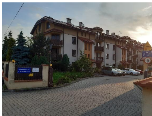
Fot. 12 Zabudowa mieszkaniowa wielorodzinną przy ul. Obozowej - widok nr 4 wg ryc. 20 (fot. B. Cichy, 20.06.2020 r.)
