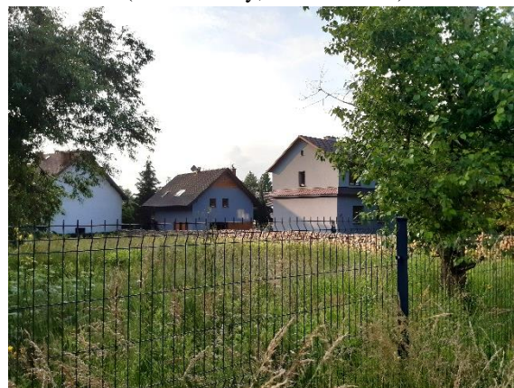
Fot. 16 Zabudowa mieszkaniowa jednorodzinna przy ul. Obozowej - widok nr 8 wg ryc. 20 (fot. B. Cichy, 20.06.2020 r.)
