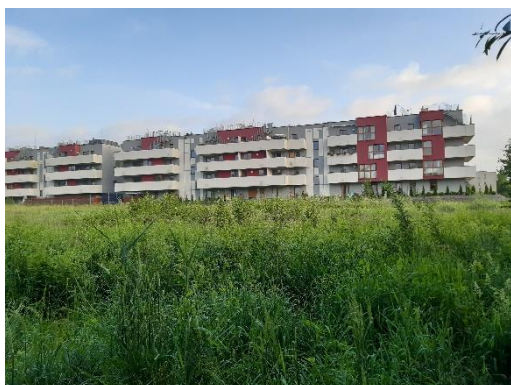
Fot. 11 Zabudowa mieszkaniowa wielorodzinną przy ul. Obozowej - widok nr 3 wg ryc. 20 (fot. B. Cichy, 20.06.2020 r.)
