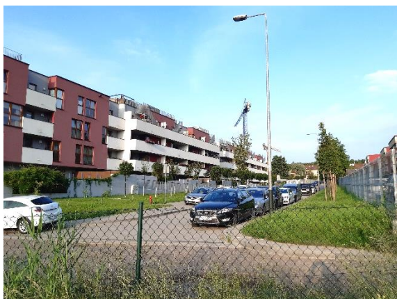
Fot.9 Zabudowa mieszkaniowa wielorodzinną przy ul. Obozowej - widok nr 1 wg ryc. 20 (fot. B. Cichy, 20.06.2020 r.)
