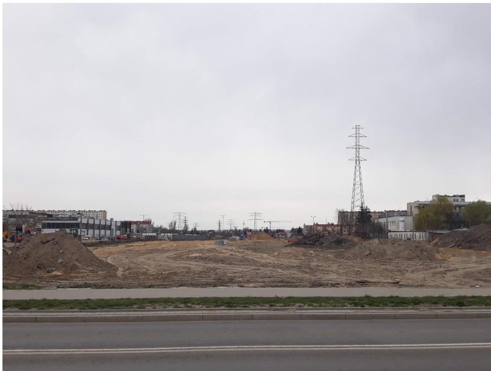
Fot. 11. Teren budowy linii tramwajowej na Górkę Narodową . Widok na teren KU.2 i KDZT.1 (kwiecień 2021 r.).
