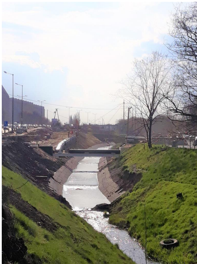
Fot. 9. Przekształcenia w obrębie koryta potoku Sudół prowadzone w związku z budową linii tramwajowej (kwiecień 2021 r.).
