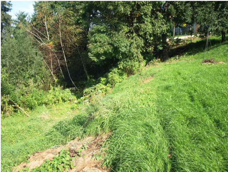
Fot. 4. Widok na osuwisko i jego skarpe główną (od południa, 2014r.) [42].
