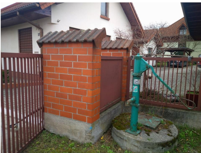
Fot. 20. Studnia przy ul. Mistrzejowickiej 15.
