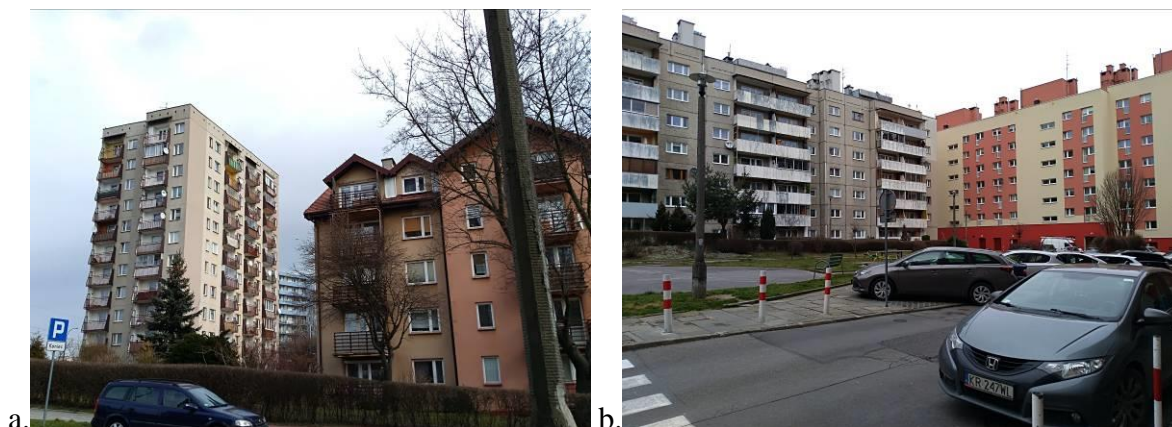
Fot. 24. Elementy obniżające ocenę krajobrazu – a. współlistnienie dysharmonijnych form (os. Bohaterów Września- część północna), b. przytłoczenie powierzchniami utwardzonymi, dysonans w stylistyce architektury (os. Bohaterów Września- część południowa)
