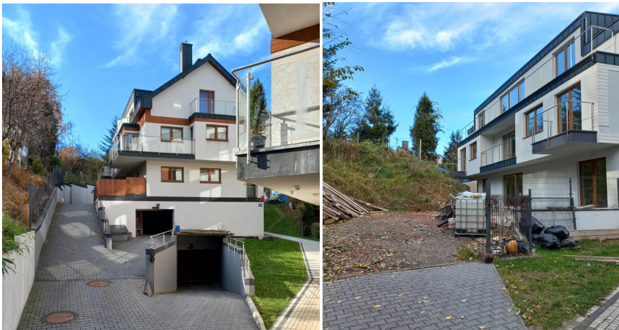
Fot. 1 Zespół zabudowy wielorodzinnej z usługami przy ul. Królowej Jadwigi (budynek zrealizowany oraz w trakcie budowy).
