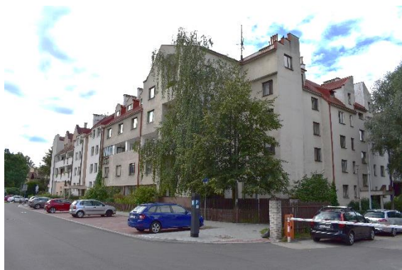
Fot. 17. Zabudowa mieszkaniowa wielorodzinną przy ul. Młaskotów - widok nr 1 2
