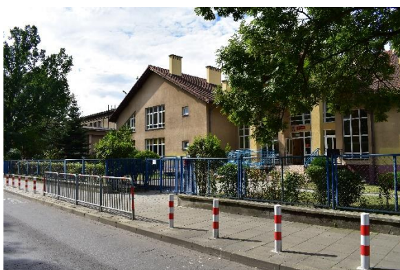
Fot. 27. Zabudowa użyteczności publicznej przy ul. Mlaskotów - widok nr 11
