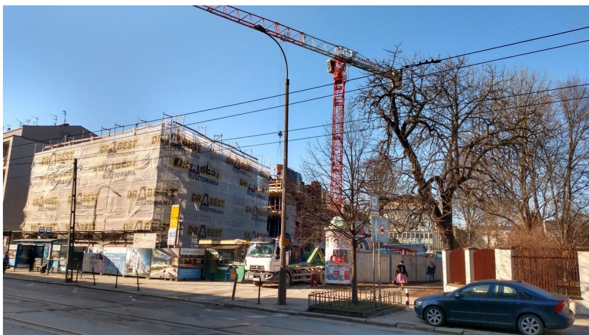
Fot. 64 Teren budowy przy ul. Kościuszki – budynek mieszkalny wielorodzinny (teren MW.13), luty 2022r.
