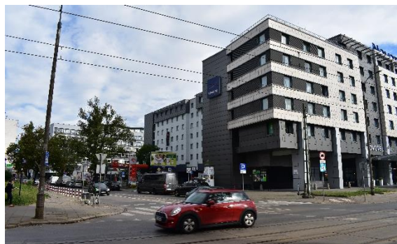
Fot. 29. Zabudowa usługowa przy ul. Kościuszki - widok nr 13
