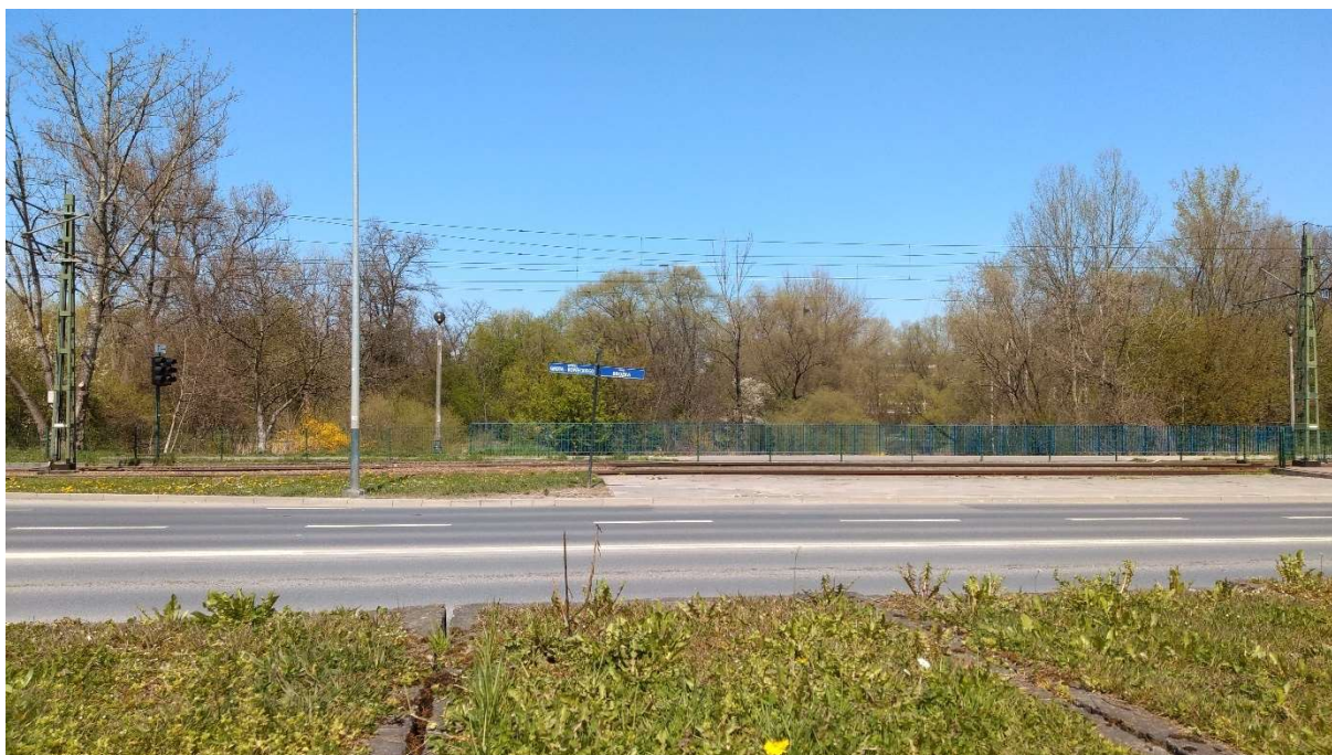
Fot. 14 Widok z ul. Brożka (nad przepustem) w kierunku Parku Rzecznego Wilga (kwiecień, 2021)
