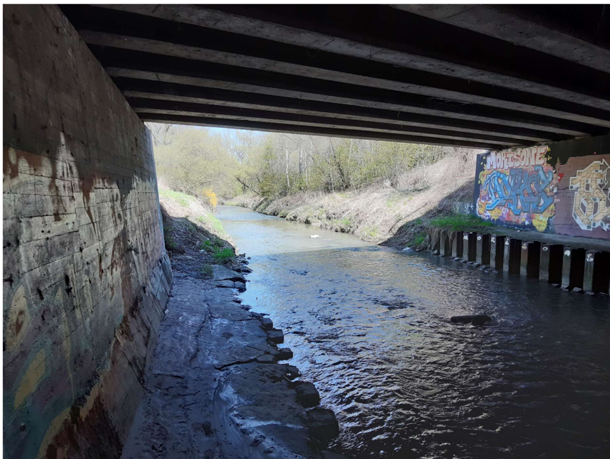
Fot. 2 Rzeka Wilga – przepust pod ul. Brożka (kwiecień, 2021).
