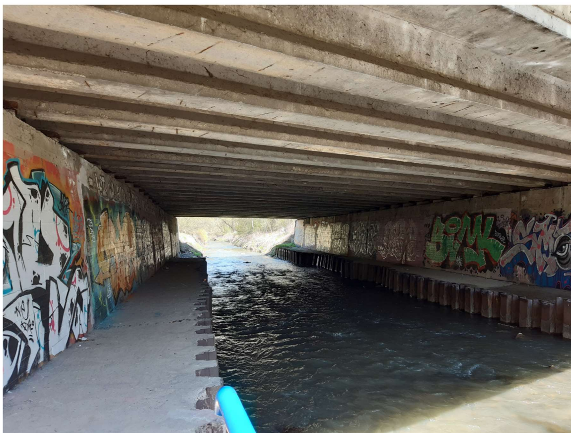
Fot. 9 Rzeka Wilga – przepust pod ul. Brożka (kwiecień, 2021)
