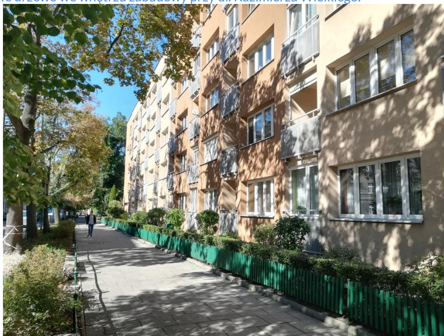
Fot. 5 Zieleń towarzysząca zabudowie oraz fragment szpaleru i zieleńca przy ul. Kazimierza Wielkiego
