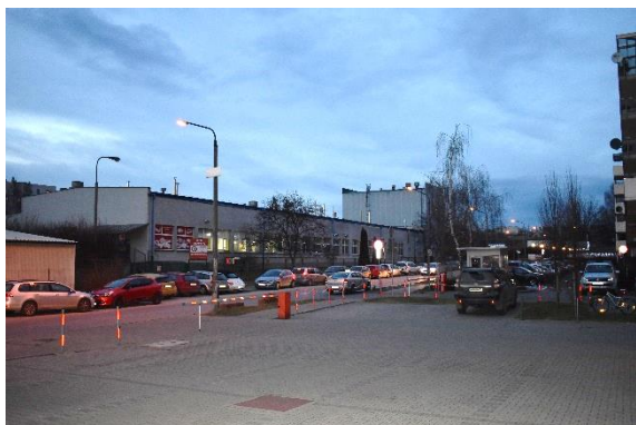
Fot. 32 Zabudowa produkcyjno - usługowa przy ul. Bociana - widok nr 20 (fot. B. Cichy, 16.02.2020 r.)
