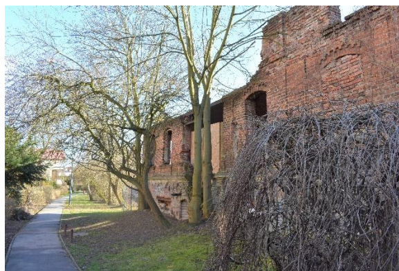
Fot. 51 Zespół dawnego młyna Bularnia, ul. Bursztynowa 5 (fot. B. Cichy, 18.02.2020 r.)
