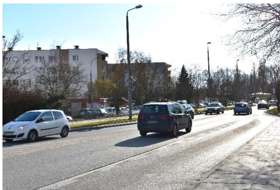
Fot. 47 ul. Mackiewicza - widok nr 35 (fot. B. Cichy, 18.02.2020 r.)
