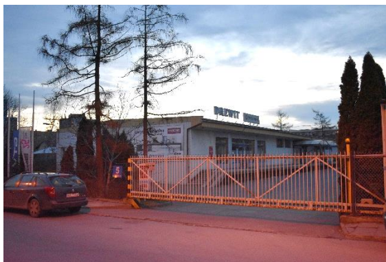
Fot. 33 Zabudowa produkcyjno - usługowa przy ul. Bociana - widok nr 21 (fot. B. Cichy, 16.02.2020 r.)
