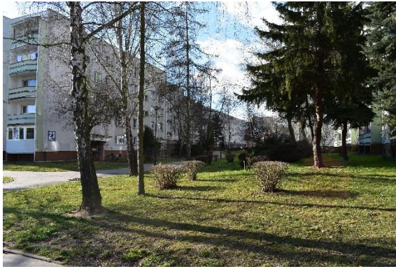
Fot. 15 Zabudowa mieszkaniowa wielorodzinna przy ul. Mackiewicza - widok nr 3 (fot. B. Cichy, 18.02.2020 r.)
