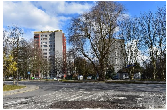
Fot. 16 Zabudowa mieszkaniowa wielorodzinna przy ul. Pachońskiego - widok nr 4 (fot. B. Cichy, 18.02.2020 r.)
