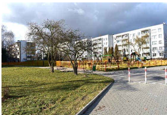
Fot.37 Skwer i plac zabaw przy ul. Mackiewicza - widok nr 25 (fot. B. Cichy, 18.02.2020 r.)
