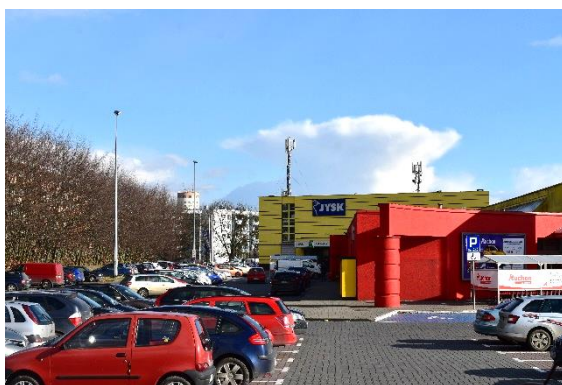
Fot. 27 Zabudowa usługowa przy ul. Mackiewicza - widok nr 15 (fot. B. Cichy, 18.02.2020 r.)
