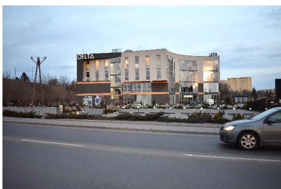
Fot. 30 Zabudowa usługowa przy alei 29 Listopada - widok nr 18 (fot. B. Cichy, 16.02.2020 r.)
