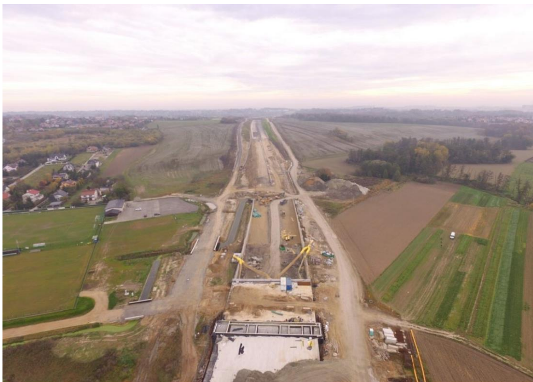
23/6:552 - 2022.10 - km 6+600 - wylot planowanego tunelu TS-04
