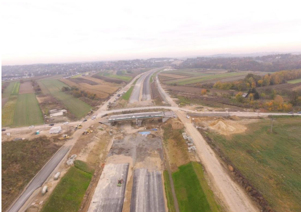
29/6:552 - 2022.10 - km 7+800 - ul. Dożynkowa (bypass) - wiadukt WD-07.
