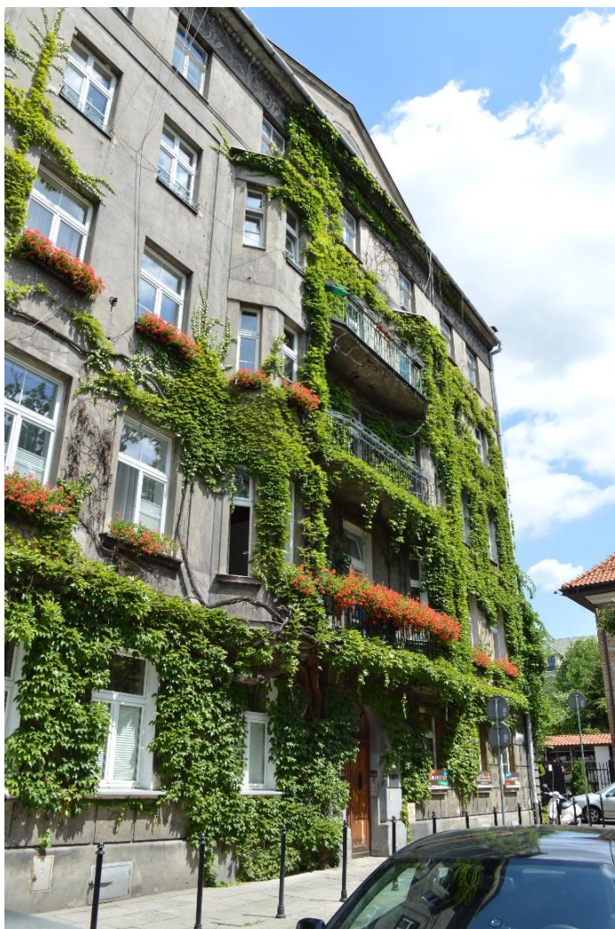
Fot. 17. Zielona elewacja kamienicy.
