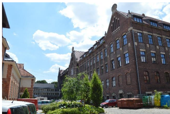
Fot. 25. Budynek Zespołu Szkół Mechanicznych.
