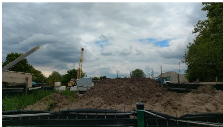
Fot. 5 Widok w kierunku wschodnim na działkę nr 284/3 obr. P-9, maj 2021r.
