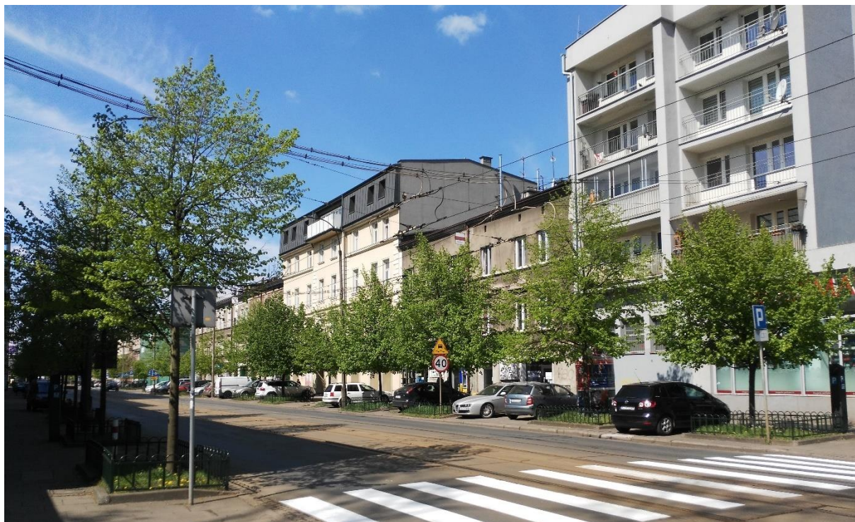
Fot. 62. Fragment strefy zielonych alei przy ul. Kościuszki (Pracownia Urbanistyczna, 2020 r.).
