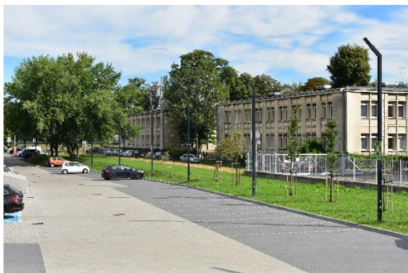
Fot. 25. Zabudowa użyteczności publicznej przy al. Focha - widok nr 9
