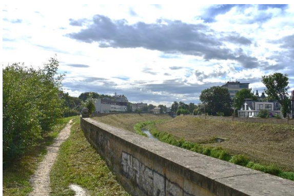
Fot. 51. Wnętrze na obwałowaniach rzeki Rudawy
