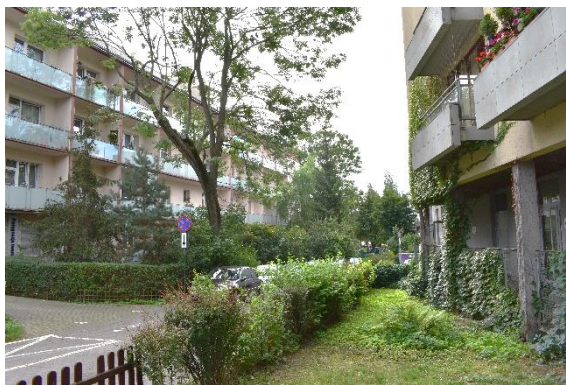
Fot. 50. Wnętrze przy ul. Senatorskiej
