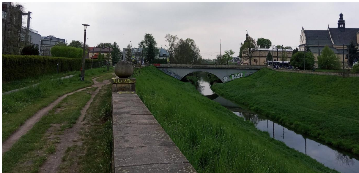
Fot. 61. Koryto rzeki Rudawy- w tle widoczny most w południowej części obszaru opracowania, w terenie KDZT.2 (Pracownia Urbanistyczna, 2020 r.).
