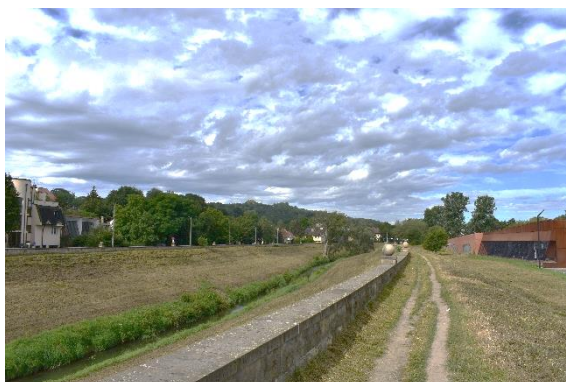
Fot. 52. Wnętrze na obwałowaniach rzeki Rudawy
