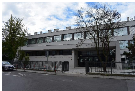
Fot. 26. Zabudowa użyteczności publicznej przy ul. Mlaskotów - widok nr 10
