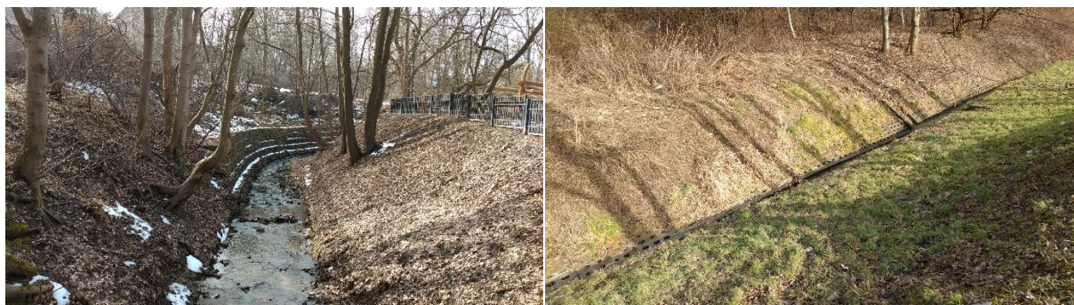
Fot. 1 Konstrukcje gabionowe na Drwince (fot. po lewej), Rów Bieżanowski (fot. po prawej).
