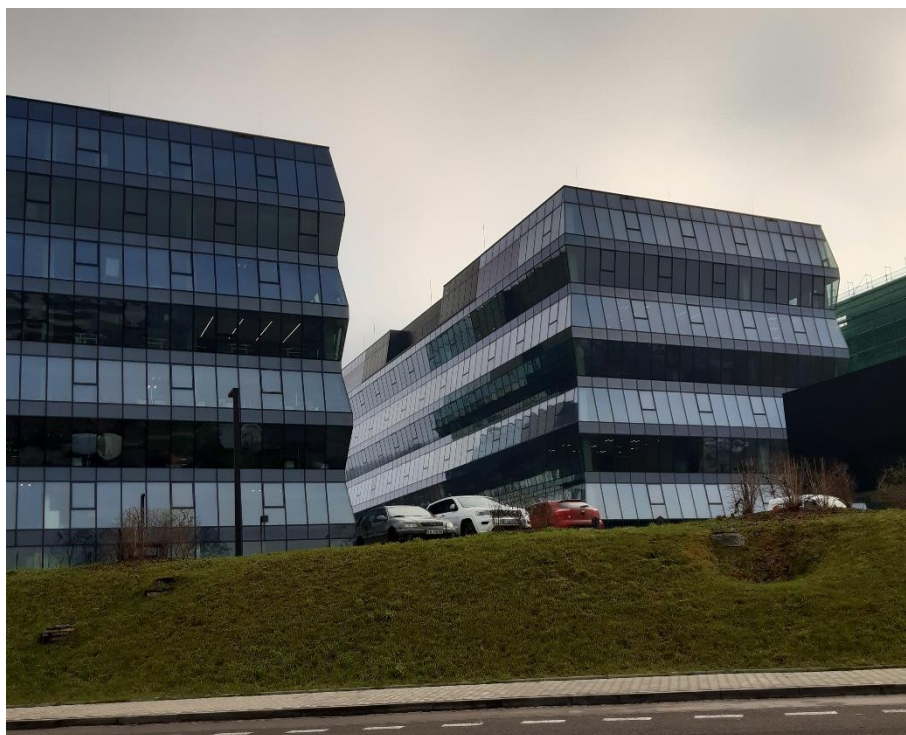
Fot. 15 Deniwelacje terenu powstałe w wyniku realizacji inwestycji biurowej przy ulicy Wadowickiej (teren U.2) (widok z ulicy Rydlówka).
