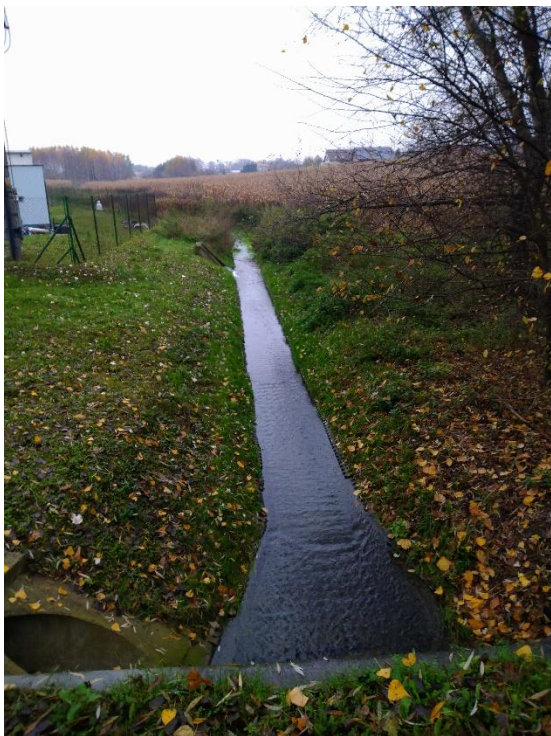
Fot. 1 Struga Rusiecka na wysokości oczyszczalni ścieków
