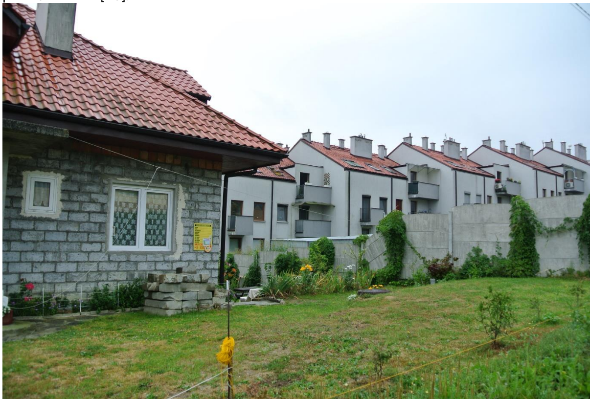
Fot. 1. Zabudowa wielorodzinna (teren MWi.1) w sąsiedztwie zabudowy jednorodzinnej przy ul. Hoborskiego (fot. Pracownia Urbanistyczna BP, lipiec 2017 r.)
