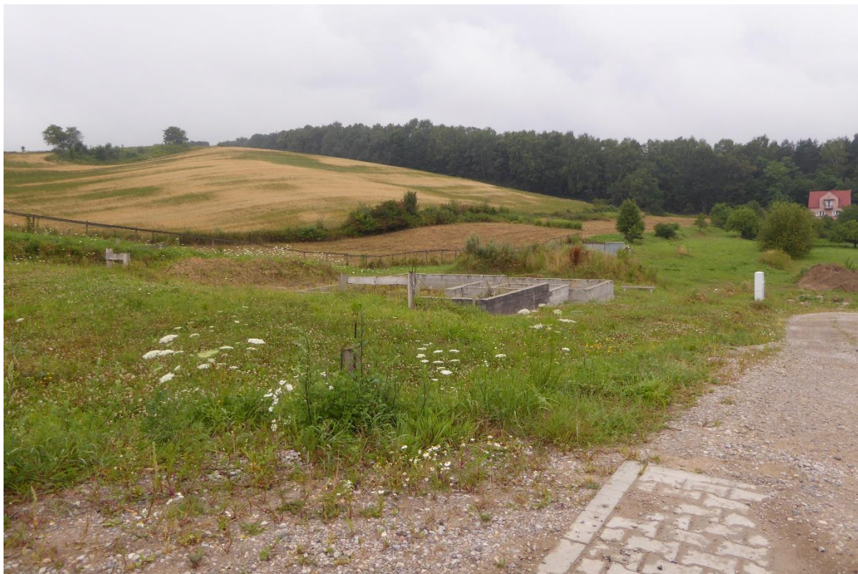
Fot. 3. Realizacja zabudowy przy ul. Hoborskiego (teren MN.19), widok w kierunku północno-zachodnim (fot. Pracownia Urbanistyczna BP, lipiec 2017 r.)
