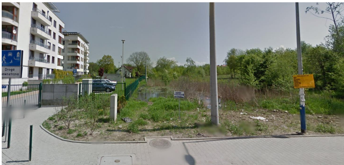
Fot. 3. Okresowe zastoiska wody przy ul. Piltza – maj 2013 r. (Google Street View, dostęp 13.09.2021 r.).
