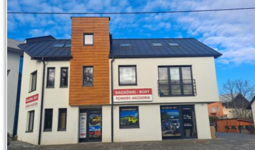
Budynek usługowo - mieszkalny przy ul. Kobierzyńskiej
