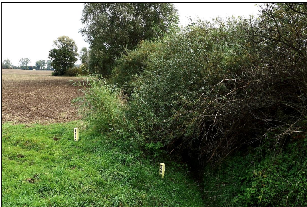
Fot. 5 Rów zbiorczy w dolnej części zlewni Potoku Kryspinowskiego. Blisko autostrady, widok w kierunku wschodnim, w górę biegu, 03.10.2019 r.
