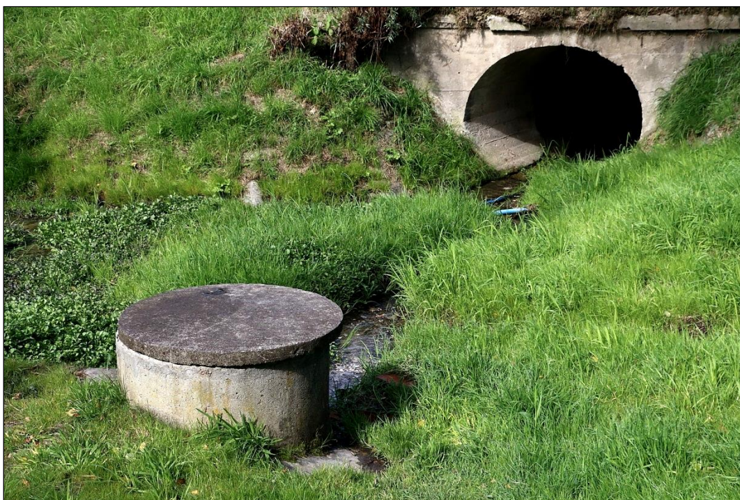
Fot. 1 Przepust pod ul. Olszanicką na odpływie ze źródła Olszanickiego. Przy ul. Olszanickiej, widok w kierunku północnym, 23.09.2019 r.
