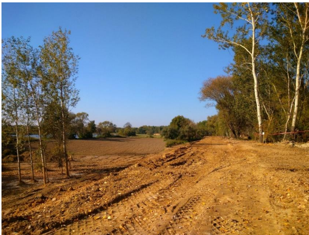
Fot. 12. Obszar międzywala Wisły z modernizowanymi wałami przeciwpowodziowymi i zielenią izolacyjną składowiska
