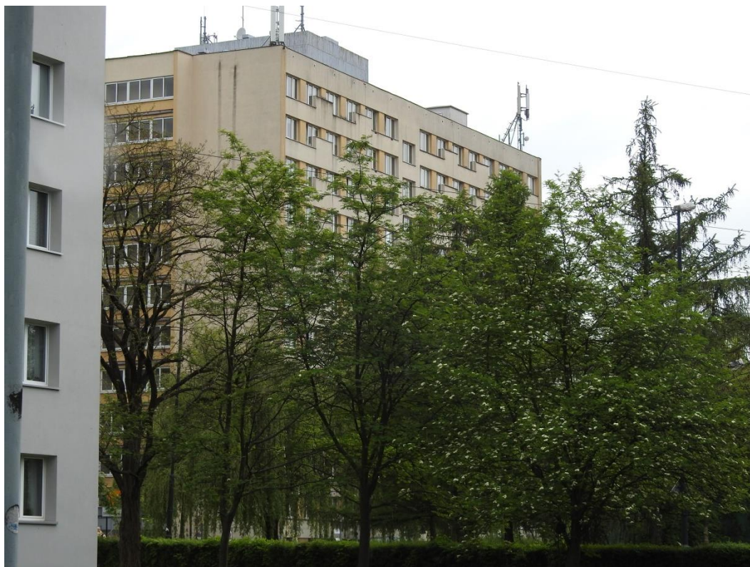
Fot. 4 Kolonie jerzyków, kawek i nietoperzy znajdują się przede wszystkim na budynkach przy ul. Skarżyńskiego i ul. Florera oraz budynkach Politechniki.
