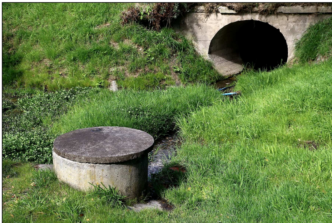
RYC. 18. PRZEPUST POD UL. OLSZANICKĄ NA ODPLYWIE ZE ŹRÓDŁA OLSZANICKIEGO Przy ul. Olszanickiej, widok w kierunku północnym, 23.09.2019 r.
