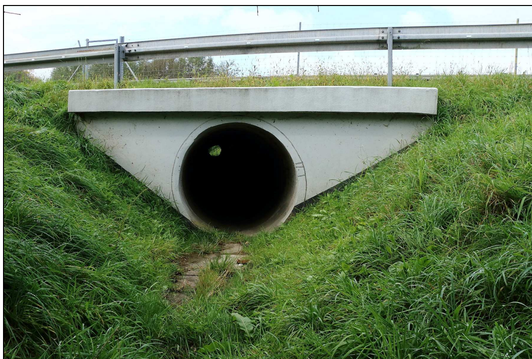
RYC. 15. PRZEPUST POD AUTOSTRADĄ A4 Zbiera wszystkie wody z części obszaru planu należącej do zlewni P. Kryspinowskiego, widok w kierunku zachodnim, w dół biegu, 03.10.2019 r.
