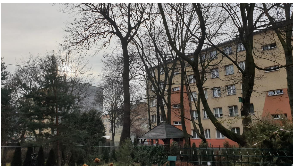
Fot. 2 „Ogródek dla mieszkańców budynku Siemaszki 54” przy zabudowie wielorodzinnej przy ul. Siemaszki, własność S.M. Krowdrza.
