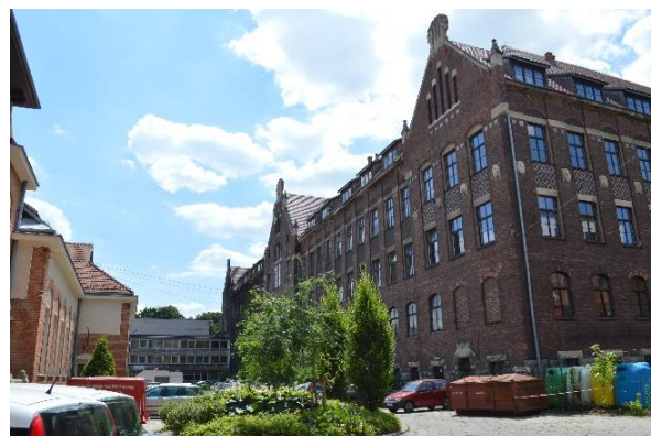
Fot. 25. Budynek Zespołu Szkół Mechanicznych.
