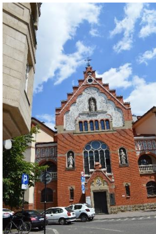
Fot. 21. Kościół pw. Najświętszego Serca Pana Jezusa.
