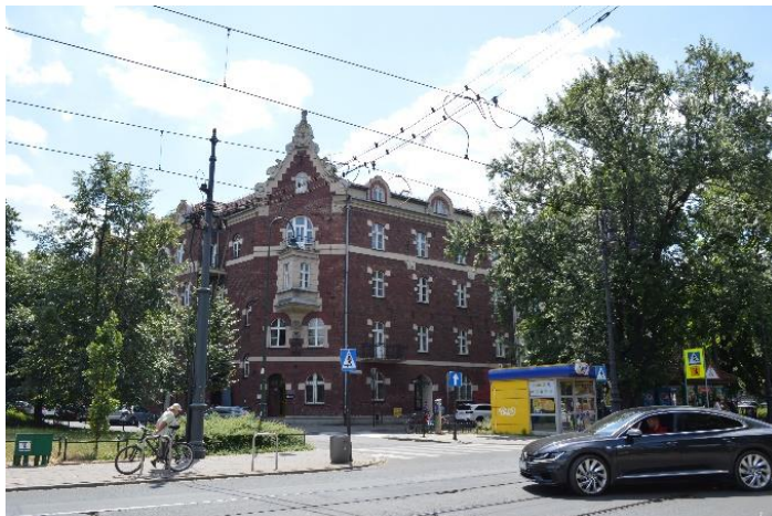
Fot. 32. Kamienica Pod Śpiewającą Żabą Teodora Talowskiego u wylotu ul. Retoryka.
