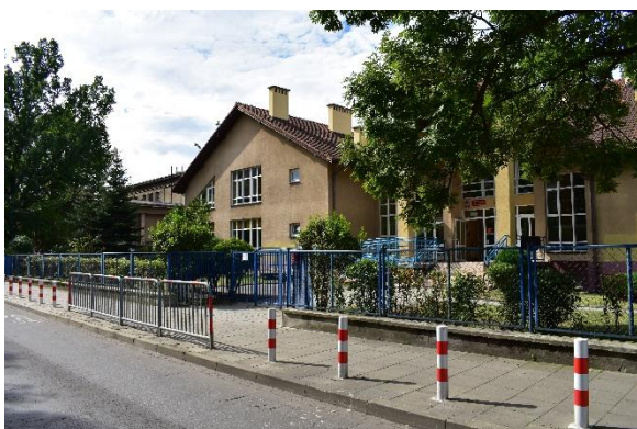
Fot. 27. Zabudowa użyteczności publicznej przy ul. Młaskotów - widok nr 11
