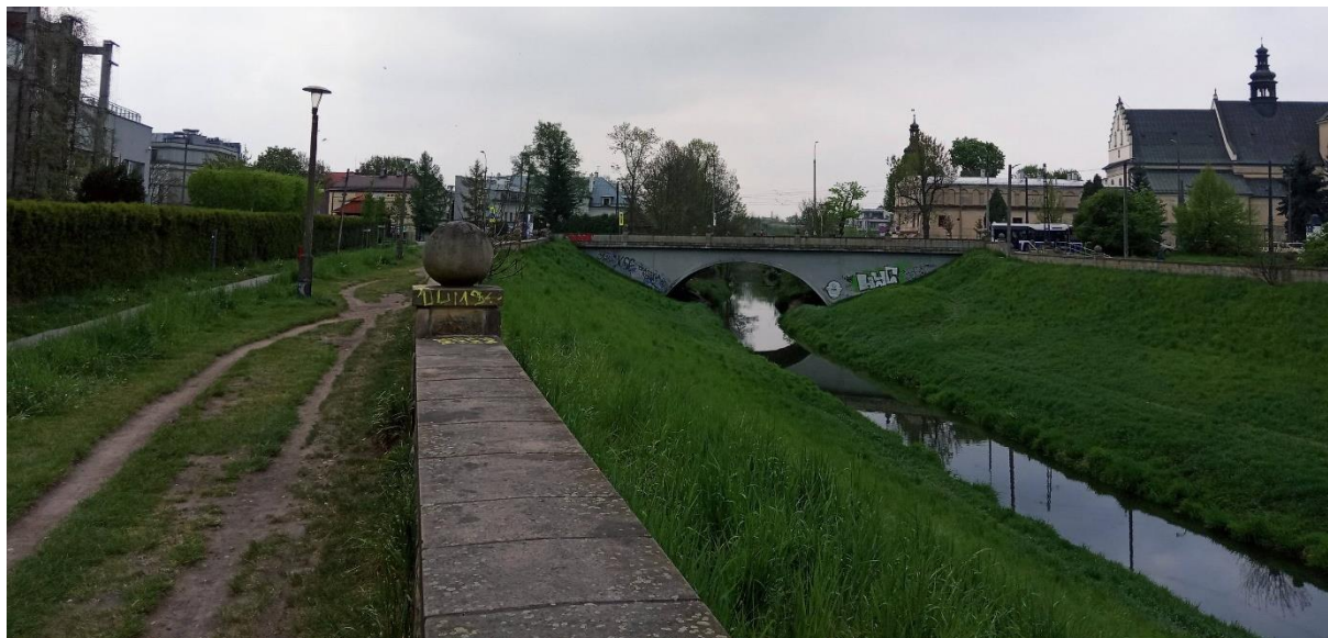
Fot. 61. Koryto rzeki Rudawy- w tle widoczny most w południowej części obszaru opracowania, w terenie KDZT.2 (Pracownia Urbanistyczna, 2020 r.).
