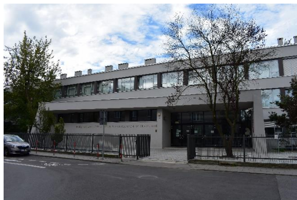
Fot. 26. Zabudowa użyteczności publicznej przy ul. Młaskotów - widok nr 10
