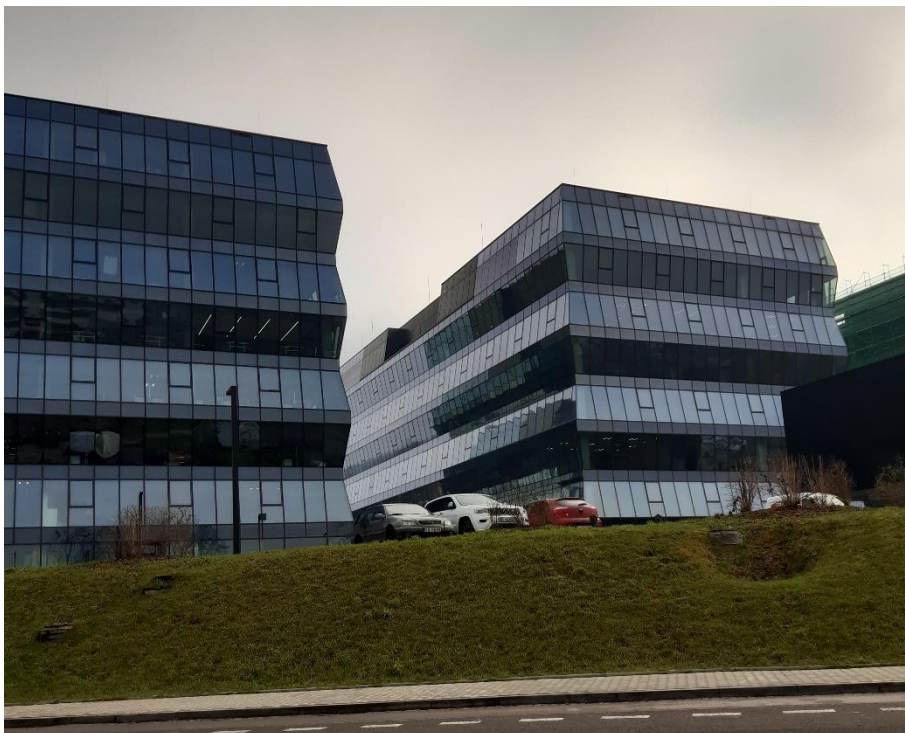
Fot. 15 Deniwelacje terenu powstałe w wyniku realizacji inwestycji biurowej przy ulicy Wadowickiej (teren U.2) (widok z ulicy Rydlówka).
