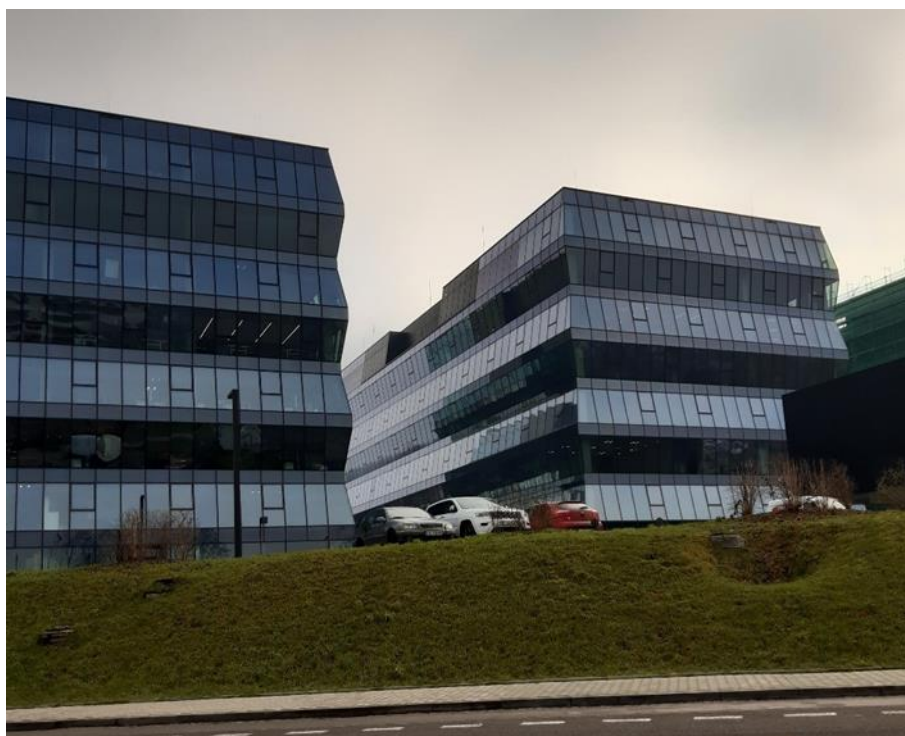
Fot. 1 Deniwelacje terenu powstałe w wyniku realizacji inwestycji biurowej przy ulicy Wadowickiej (widok z ulicy Rydlówka).
