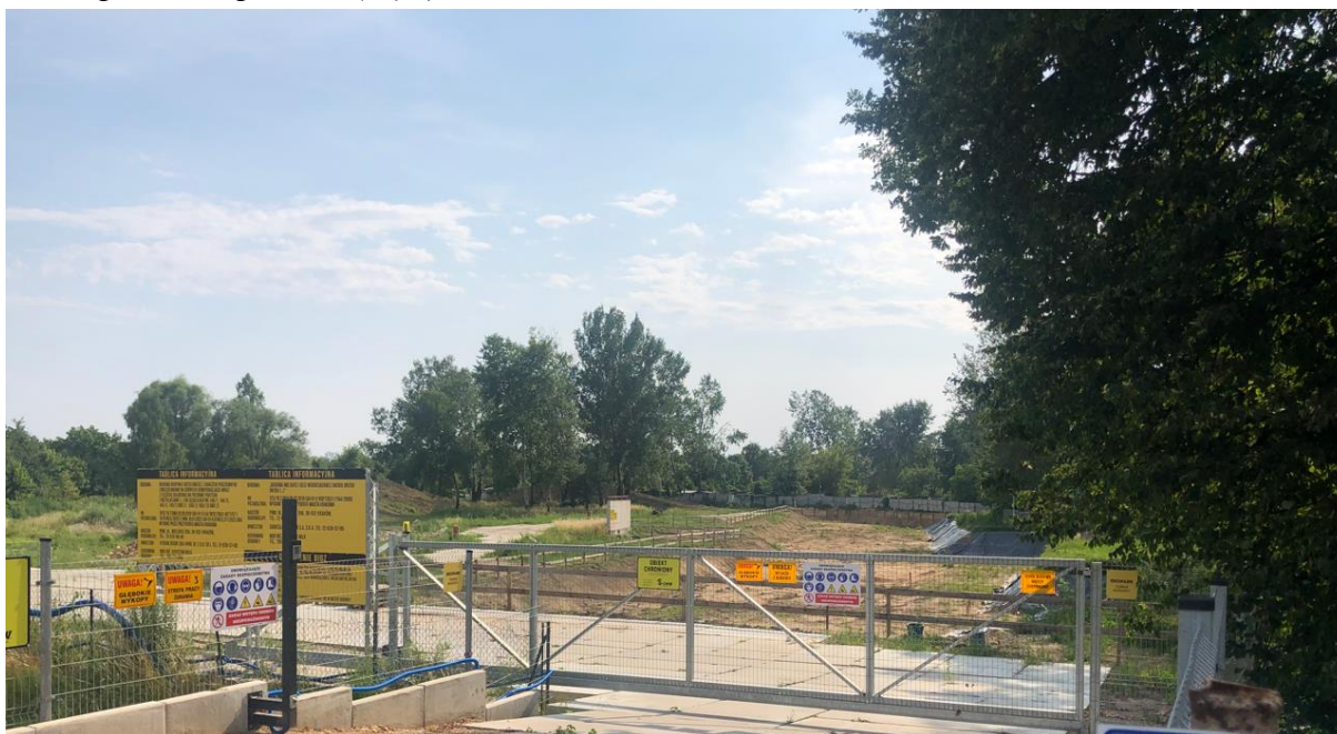
Fot. 1. Prace budowlane realizowane w obrębie terenu MW/U.3 (07.2023).
