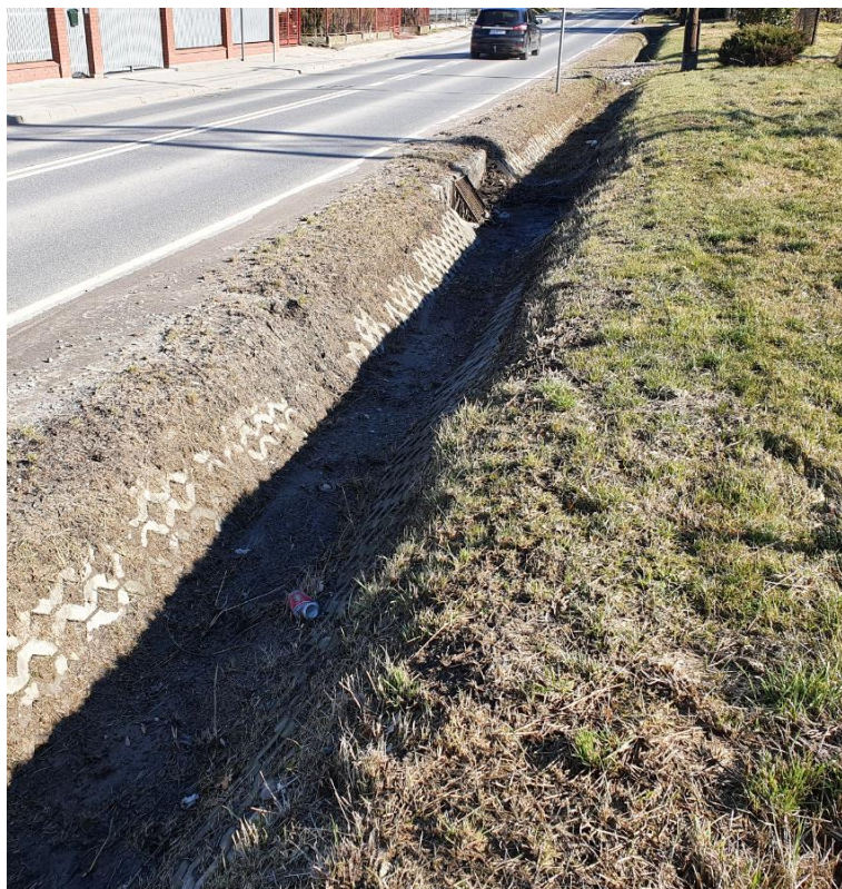
Fot. 2. Rów odwadniający wzdłuż ul. Rząckiej.
