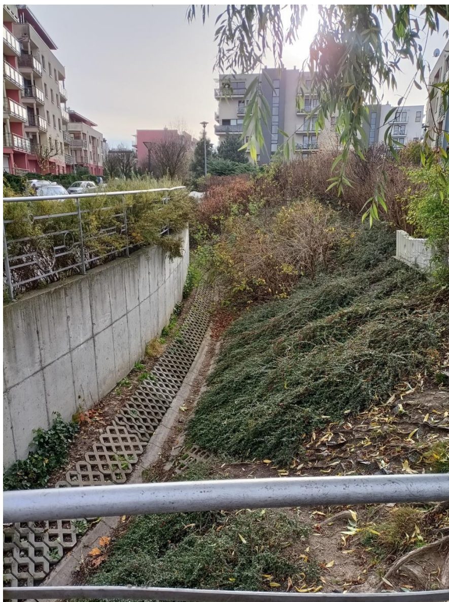
Fot. 1. Fragment umocnionego rowu (nazywanego Rów Chmieleniec) przy terenie zainwestowanym w obszarze opracowania.
