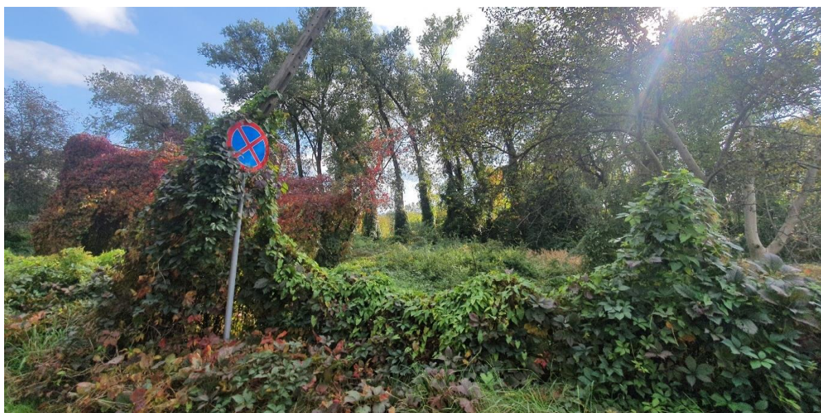
Fot. 10. Fragment dawnego ogrodzenia działki rekreacyjnej, która została zniszczona i porośnięta między innymi winobłuszczem pięciolistkowym.
