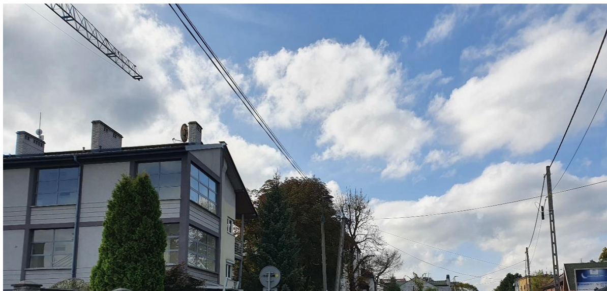
Fot. 9. Nisko zawieszono linie elektroenergetyczne przy ul. Zarzecze.
