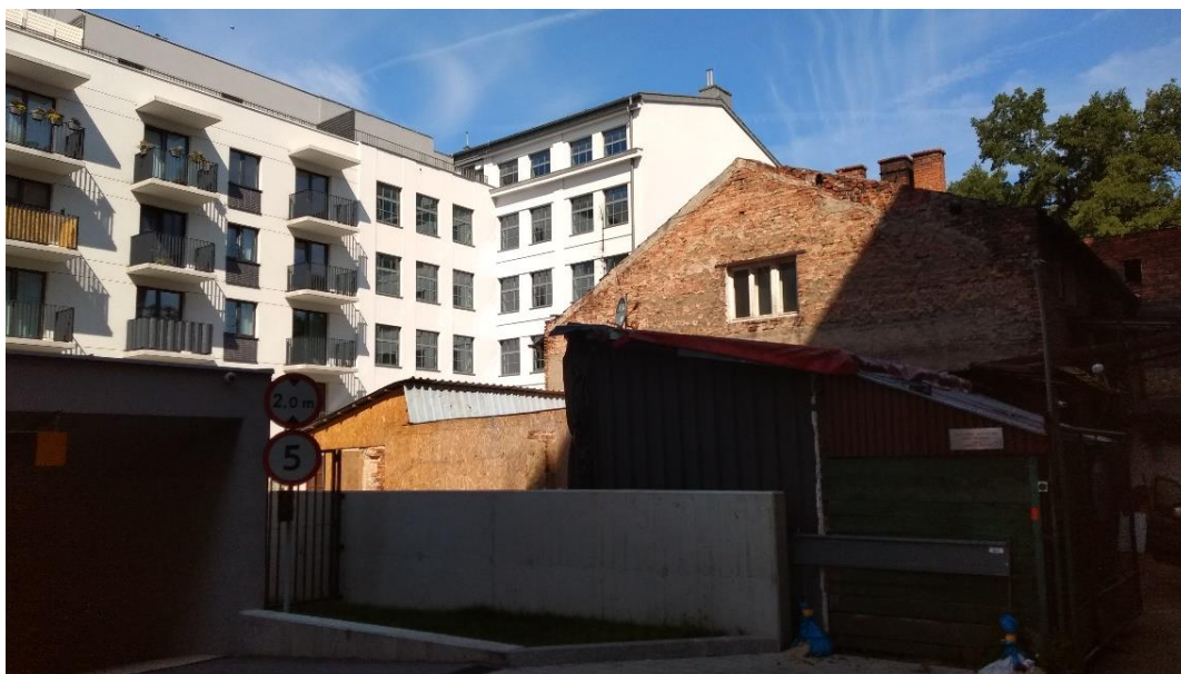
Fot. 18. Zabudowa przy ul. Słomnickiej.
