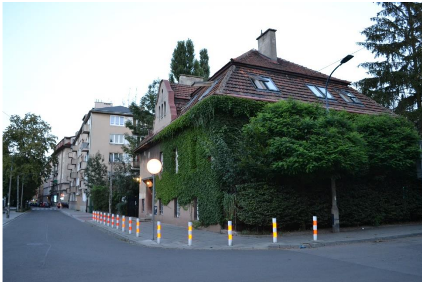
Fot 7. Zielona elewacja budynku przy ul. Salwatorskiej (fot. B. Dudzic, 24.08.2020 r.).
