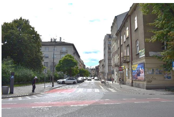
Fot. 53 Oś widokowa ul. Borelowskiego - Lelewela – w kierunku ul. Kościuszki (fot. B. Cichy, 17.08.2020 r.)
