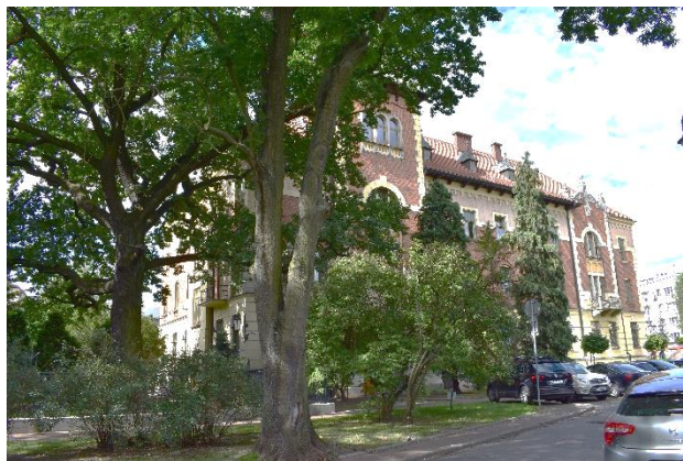
Fot. 44 Zespół administracyjno – gospodarczy i przemysłowy Miejskiego Przedsiębiorstwa Wodociągów i Kanalizacji, ul. Senatorska 1 / ul. Łowiecka 2
