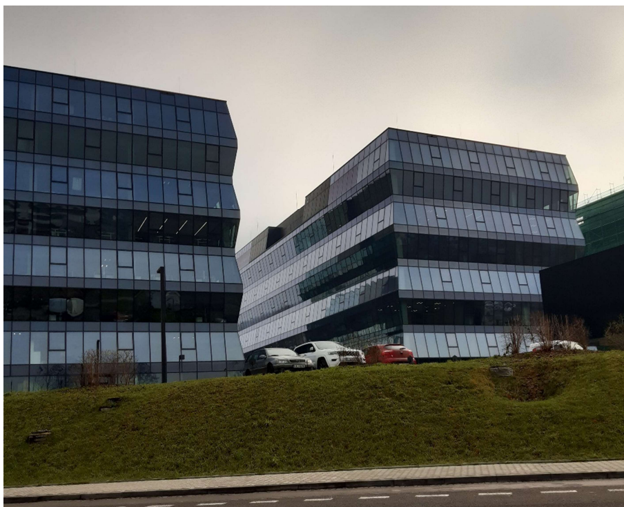
Ryc. 4. Deniwelacje terenu powstałe w wyniku realizacji inwestycji biurowej przy ulicy Wadowickiej (widok z ulicy Rydlówka).
