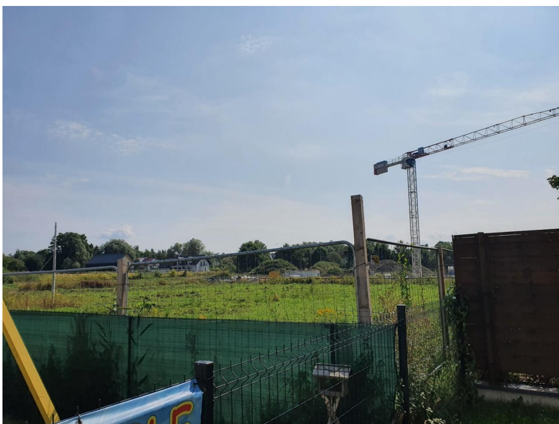
Fot. 13. Widok na teren MW.4 od ul. Piltza w kierunku południowo-wschodnim (wrzesień 2021r.).
