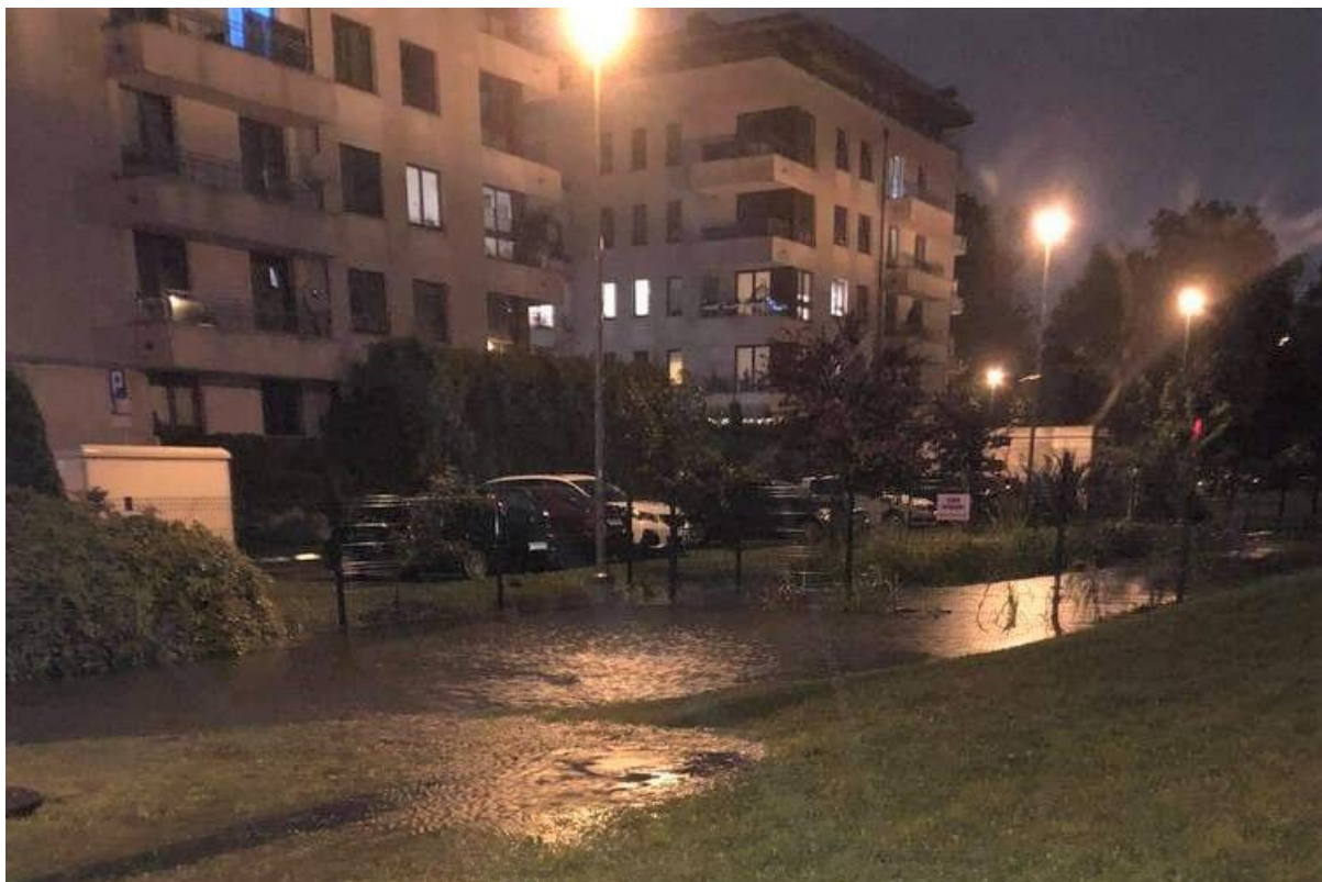
Fot. 10. Lokalne zaleganie wód opadowych w obniżeniach terenu przy ul. Piltza – 05.08.2021 r. (fot. www.gazetakrakowska.pl , autor: czytelnik). Widok na fragmenty terenów MW.2, KDX.1, MW.3.
