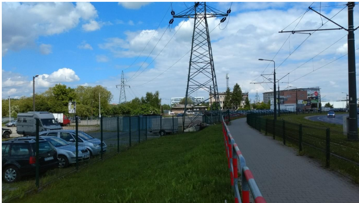
Fot. 22 Linia wysokiego napięcia przebiegająca przez środkową część obszaru opracowania, widok w kierunku północno-wschodnim, maj 2021 r.
