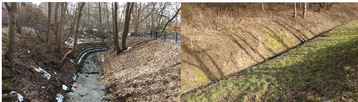
Fot. 1 Konstrukcje gabionowe na Drwince (fot. po lewej), Rów Bieżanowski (fot. o prawej).
