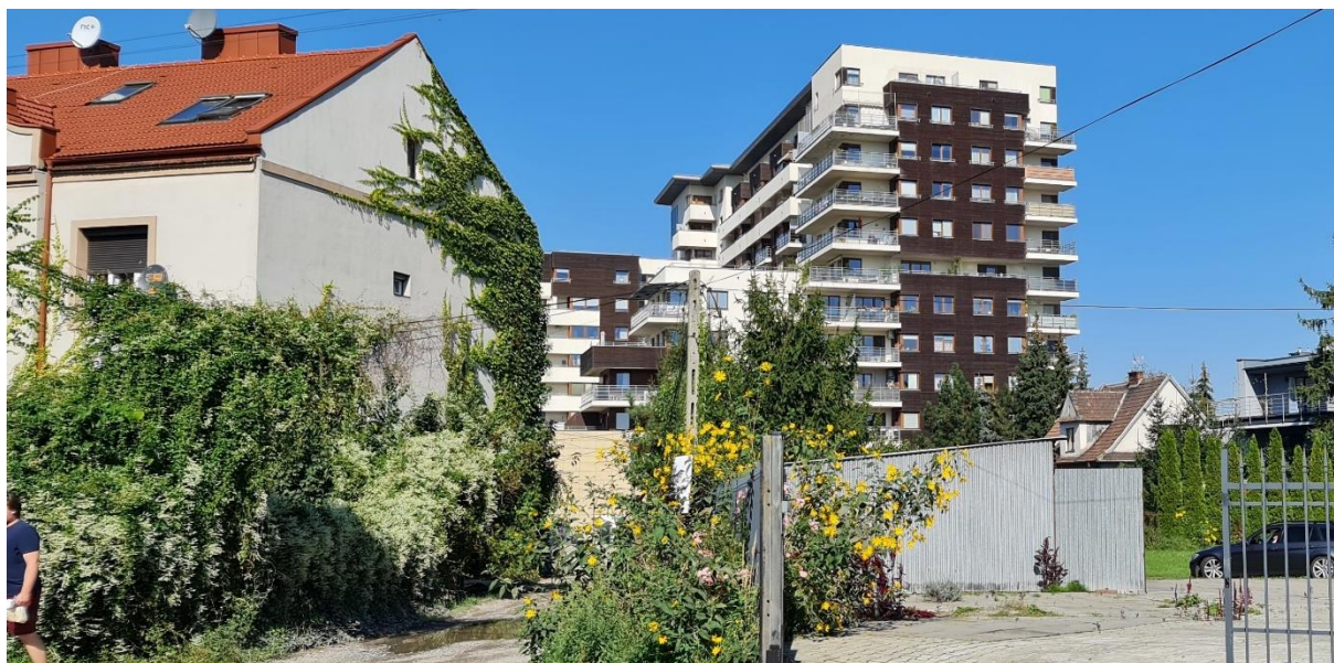
Fot. 6. Zabudowania jednorodzinne przy ul. Ruczaj z zabudową wielorodzinną przy ul. Miłkowskiego w tle.
