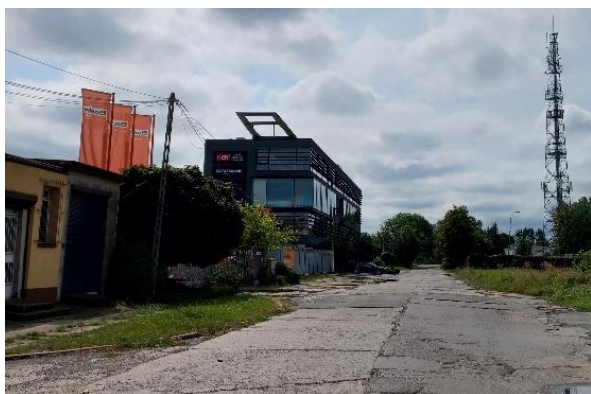
Fot. 16. Nowoczesny budynek kontrastujący ze starą zabudową i zaniedbanym otoczeniem
