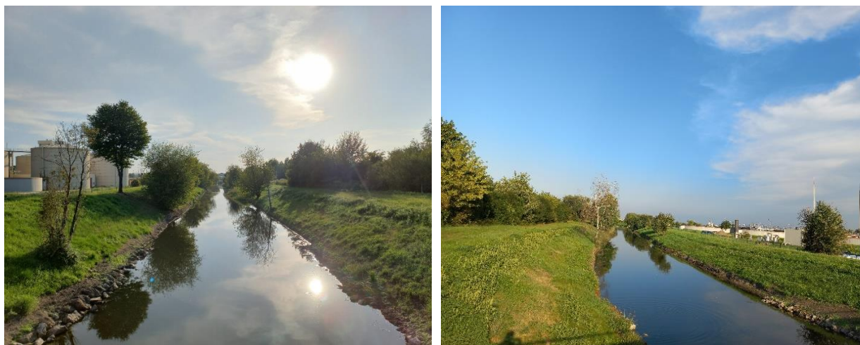
Fot. 21. Widok na Drwinę Długą w kierunku zachodnim (po lewej stronie) i wschodnim z mostu przy oczyszczalni ścieków Płaszowie.
