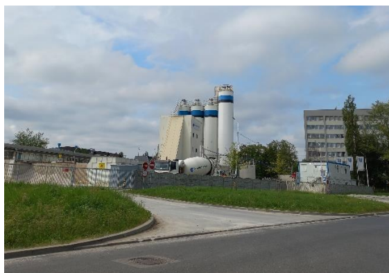
Fot. 17. Widok na betoniarnię i budynek usługowy przy ul. Płk. Stanisława Dąbka.
