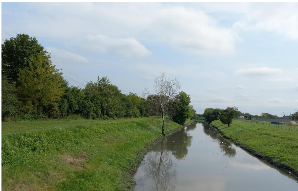
Fot. 9. Mewy obserwowane nad Drwiną Długą w rejonie oczyszczalni ścieków, sierpień 2023 r.
