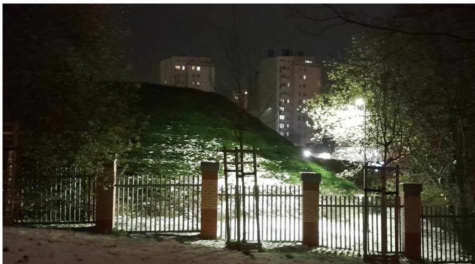
Fot. 3. Widok zbiorników wodociągowych na Os. Na Stoku w porze nocnej.
