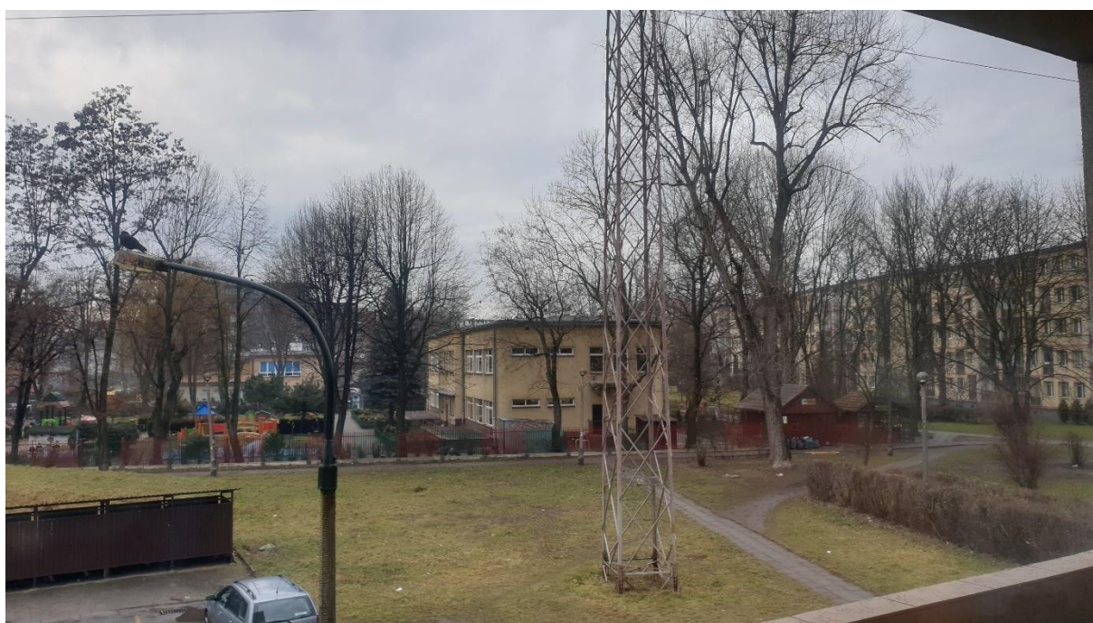
Fot. 19. Słup linii wysokiego napięcia przy ul. Bobrzeckiej (luty, 2020 r.)
