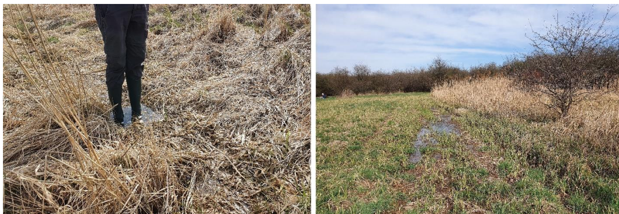
Ryc. 25. Liczne podmokłości w terenie obserwowane w czasie wizji terenowej w kwietniu 2022 r.
