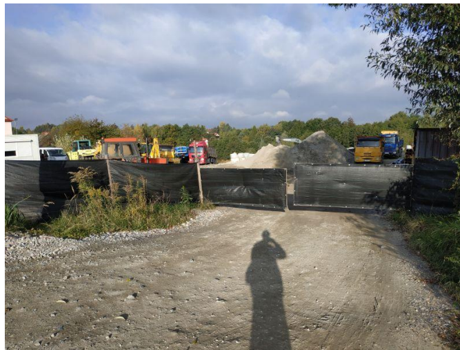
Fot. 14. Plac budowlany, ul. Drużbackiej. (fot. M. Chrząszczyk 16.10.2021 r.).
