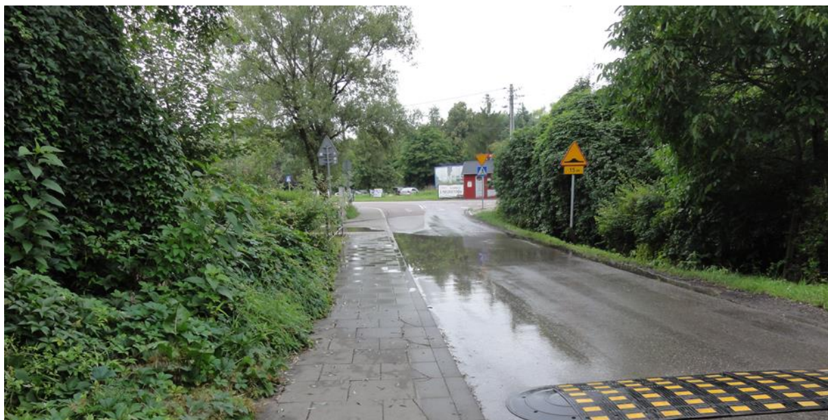
Fot. 11. Miejsce przepustu Potoku Młynnego Kobierzyńskiego pod ulicą Skośną, przy skrzyżowaniu z ulicą Lubostroń (fot. lipiec, 2021r.).
