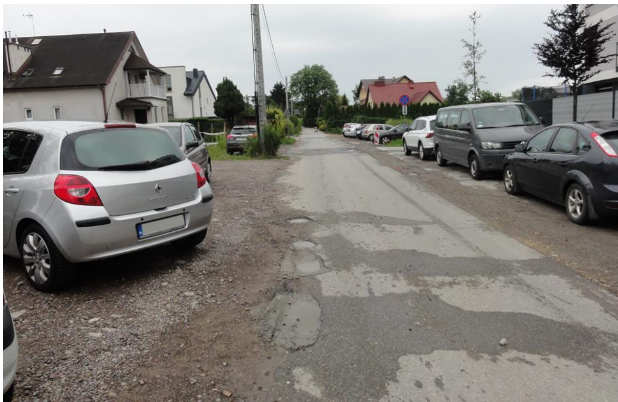
Fot. 20. Granica pomiędzy obszarem o zabudowie wielorodzinnej i jednorodzinnej w południowej części ulicy Piltza. Widoczny problem niewystarczającej ilości ogólnodostępnych miejsc parkingowych obok budynków wielorodzinnych (for. Lipiec. 2021r.).
