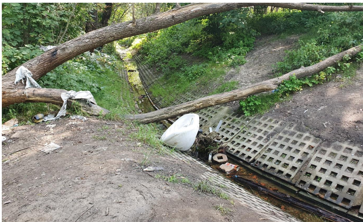
Fot. 13. Śmieci w Potoku Młynnym Kobierzyńskim przy skrzyżowaniu ulicy Skośnej i Lubostroń (fot. Lipiec 2021r.).
