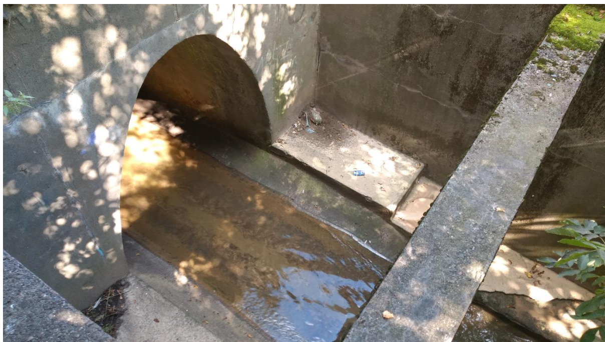
Fot. 4. Wylot zarurowanego odcinka Sudołu Dominikańskiego do Białuchy, wrzesień 2021 r.
