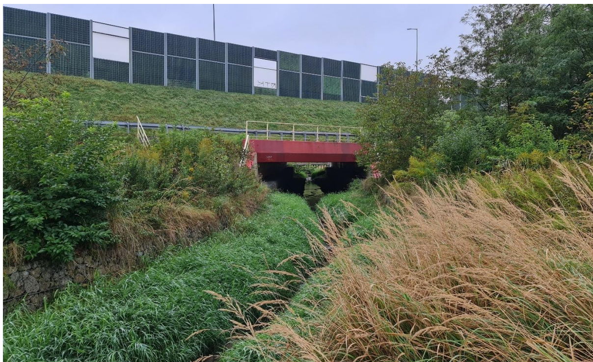
Fot. 1 Przebieg ciek Malinówka pod nasypem autostrady. Połączenie ekologiczne wzdłuż ciek jest możliwe.
